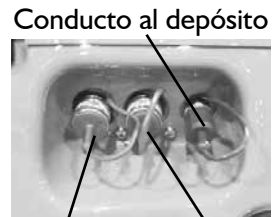
Conducto al depósito Presión 1 Presión 2
